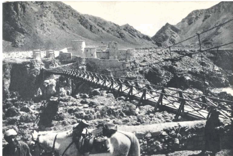
Auprès d'un ancien fort, le pont suspendu à Kalatsé.
